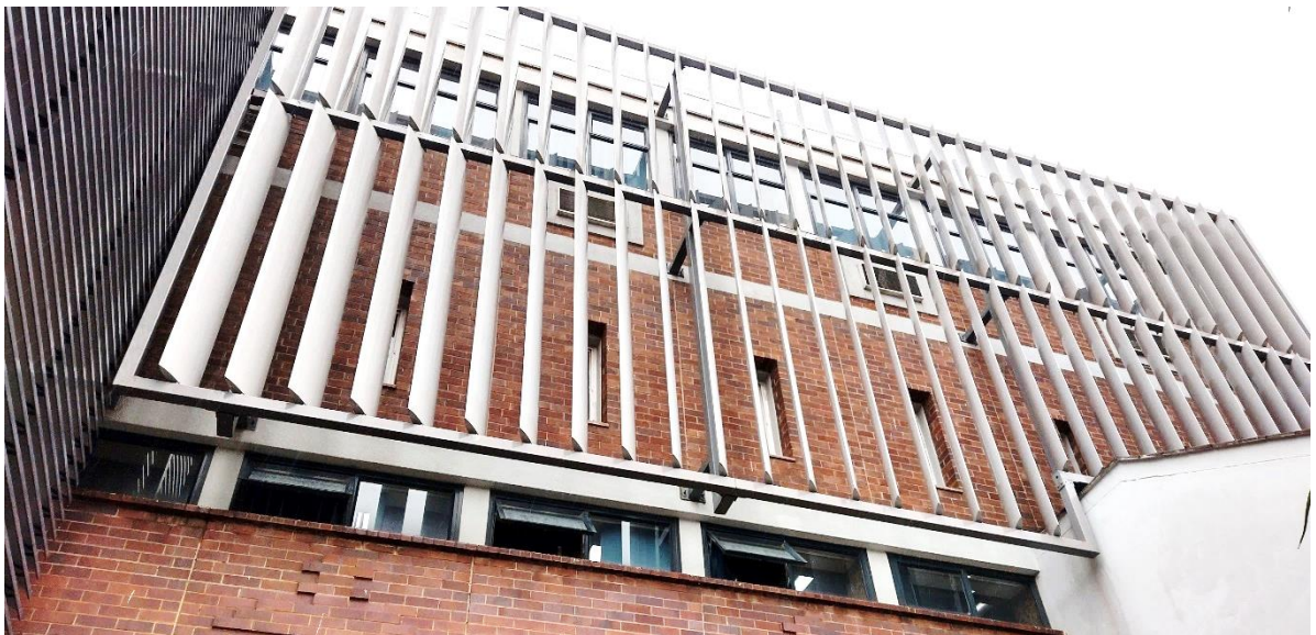
Exemple de persiennes solaires appliquées à un bâtiment public de la ville d'Ekurhuleni (Margaret Avenue, Kempton Park). Source: photo de Koen De Ridder.
